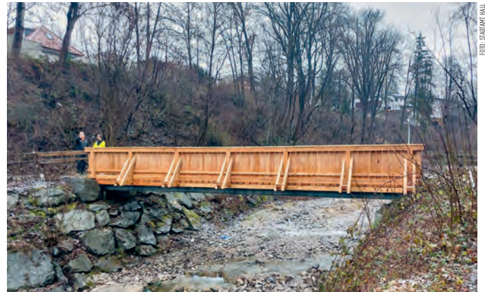
Da die Brücke über den Weißenbach im Bereich zwischen Milser Straße auf Haller Stadtgebiet und dem Weideweg in Mils in die Jahre gekommen war, musste diese saniert werden. Kurz vor Weihnachten konnte das Gemeinschaftsprojekt abgeschlossen und die Brücke wieder freigegeben werden.
