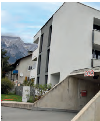
Die 2. Baustufe erfolgt im selben Stil, wie die bereits errichtete 1. Baustufe.
