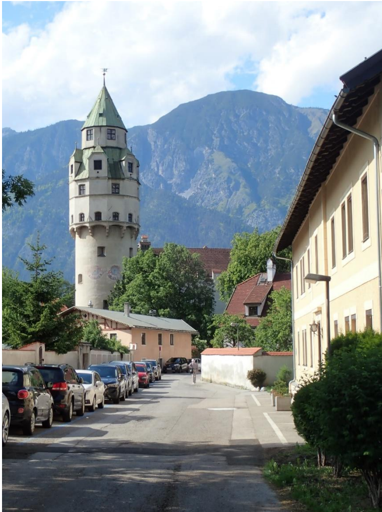
Abb. 11: Sichtkegelrichtung 6 von Münzergasse Richtung Münzerturm
